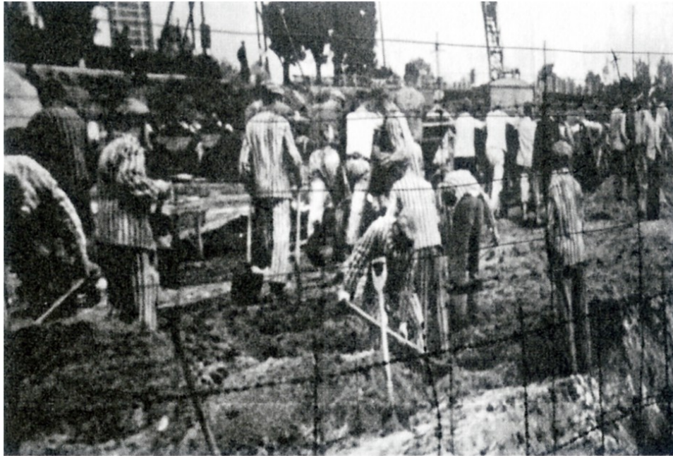
Terrassement de la Briqueterie
